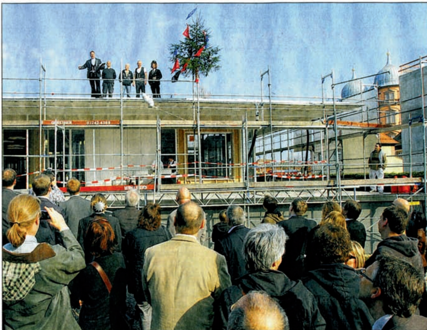
DER BAU DER KITA „Schloss-Geister“ auf dem BGV-Gelände gehen in die Endphase. Ab dem 1. Juli 2011 sollen dort 55 Kinder betreut werden. Foto: jodo
